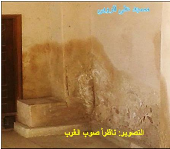
صورة رقم (٢): تأثير إرتفاع المياه بمدخل هرم هواره. صورة رقم (٣): تأثير إرتفاع المياه بمسجد على الروبي.
