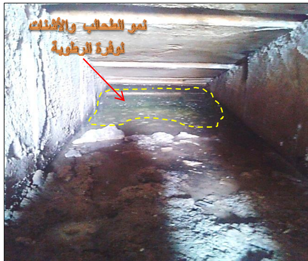
صورة رقم (٨): نمو الطحالب بالمياه بمدخل هرم هواره.
