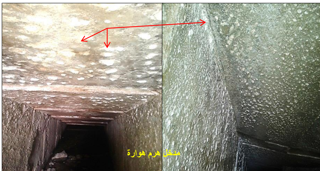
صورة رقم (١٠): التبلور الملحي بمدخل هرم هواره.
