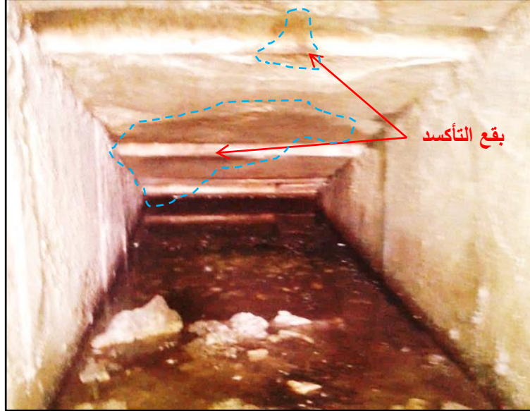
صورة رقم (١): تأكسد الأحجار الجيرية بمدخل هرم هواره.
