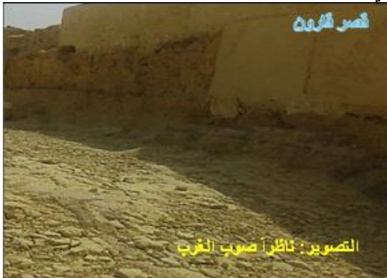
صورة رقم (٥) تآكل بعض أساسات حوائط
