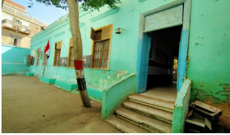
لوحة رقم (٤) الواجهة الشمالية لمدرسة المساعي المشكورة .
