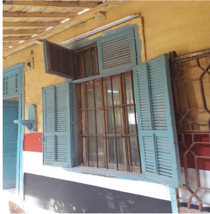
لوحة رقم (١٤) شباك يفتح على غرفة المعمل بالجناح الشرقي للمدرسة .
