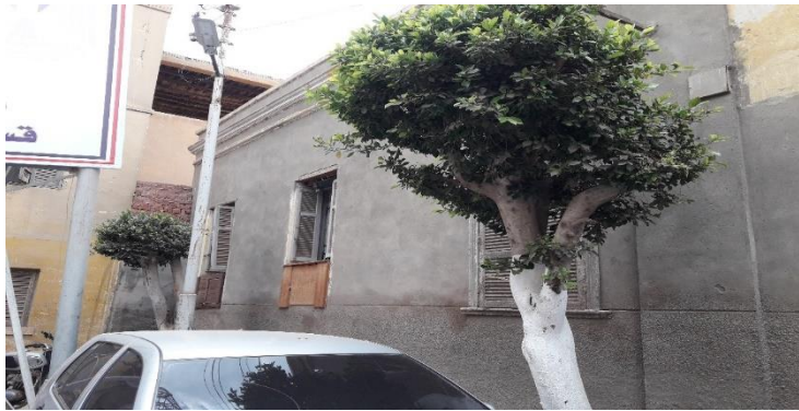
لوحة رقم (٣) ثلاثة شبابيك بالجانب الأيمن من الواجهة الرئيسية لمدرسة المساعي .
