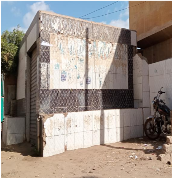
صورة (٩) محطة تنقية مياه أهلية (الأخماس)
