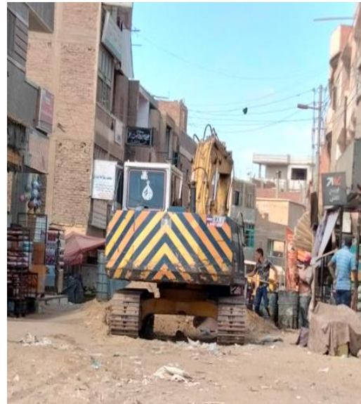
صورة (٢٠) أعمال حفر شبكة الصرف الصحي (الخطاطبة المحطة)
