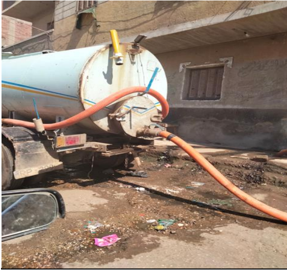
صورة (١٩) التلوث البيئي بمياه الصرف الصحي (بقرية الجيار)
